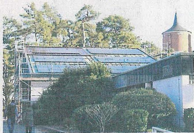
66 Module der Photovoltaikanlage bilden sechs Felder, die zusammen 110 Quadratmeter Fläche bedecken. Das braune Trapezblech unterscheidet sich deutlich vom Kupfer. FOTO: BP
