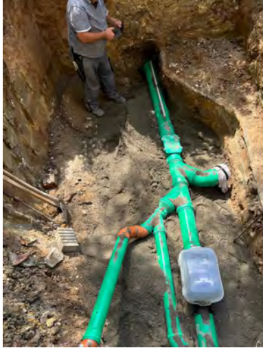
SANIERUNG KANAL WEG OBERTSHAUSEN
